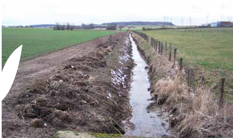
Curage d'un fossé
