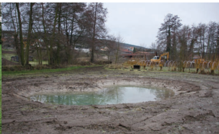
Chantier de création de mare sur une parcelle agricole. © Alexandre Gonçalves
